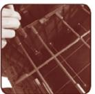
Vissez manuellement de façon modérée, tout en appuyant fortement sur le Moduls, jusqu'à ce que la tête de vis soit en contact avec le puit.
