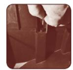
Positionnez les 8 vis fournies par Moduls dans leur puits et obligatoirement 2 jonctions entre les Moduls.
